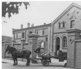
Patzenhoferbrauerei Frankfurter Straße/ Ecke Kirchhofstraße
