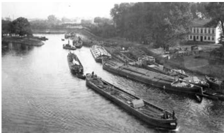
Hafen Fürstenwalde Südseite vor dem Brückenbau
